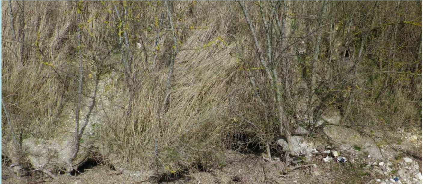
Erosion de la base
