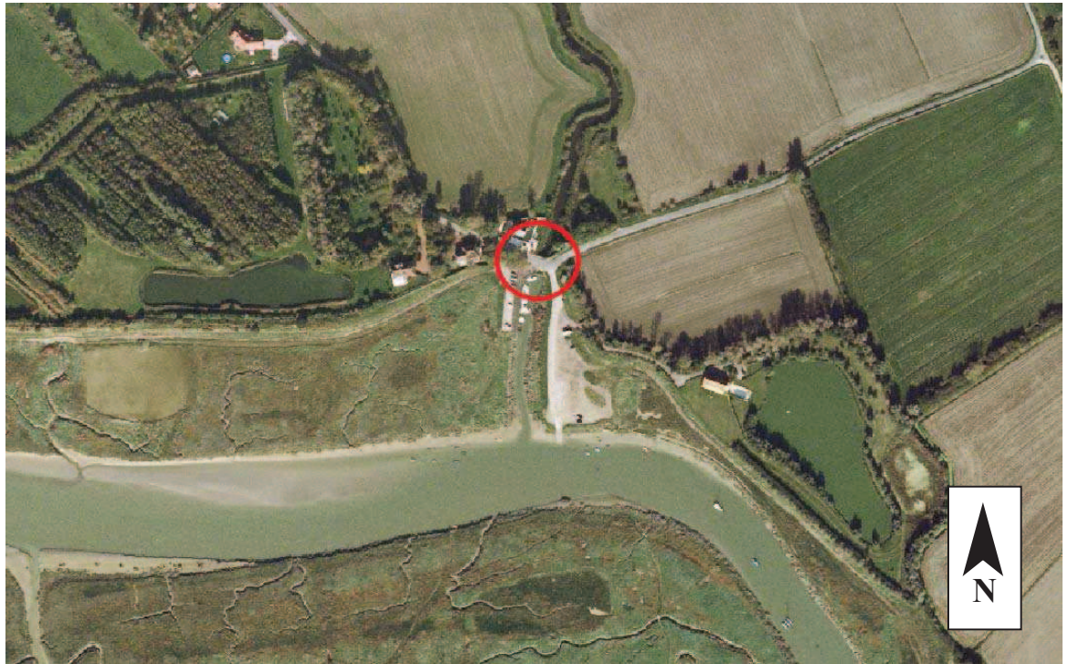
Figure 8-328: Localisation de l'ouvrage défaillant de la Madelon à Groffliers
