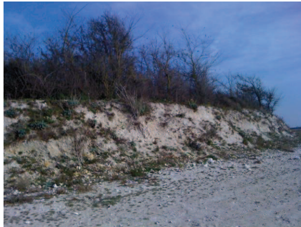
Figure 2.4 – Talus érodé de la digue de La Mollière
