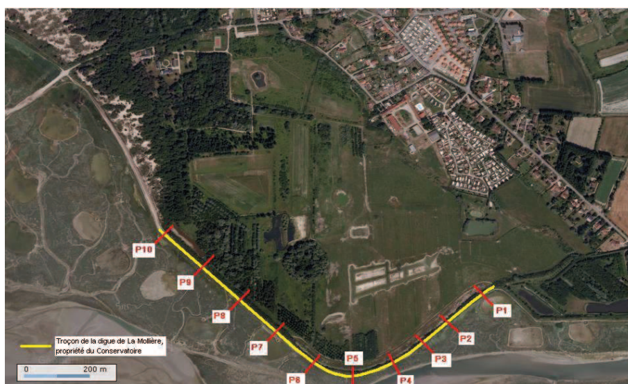
Figure 5.1 Profils levés de la digue de La Mollière
