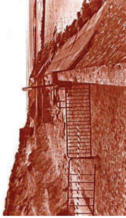
Berck-Plage - Tempête de février 1990 - Recul du cordon dunaire et destruction partielle des ouvrages de défense
