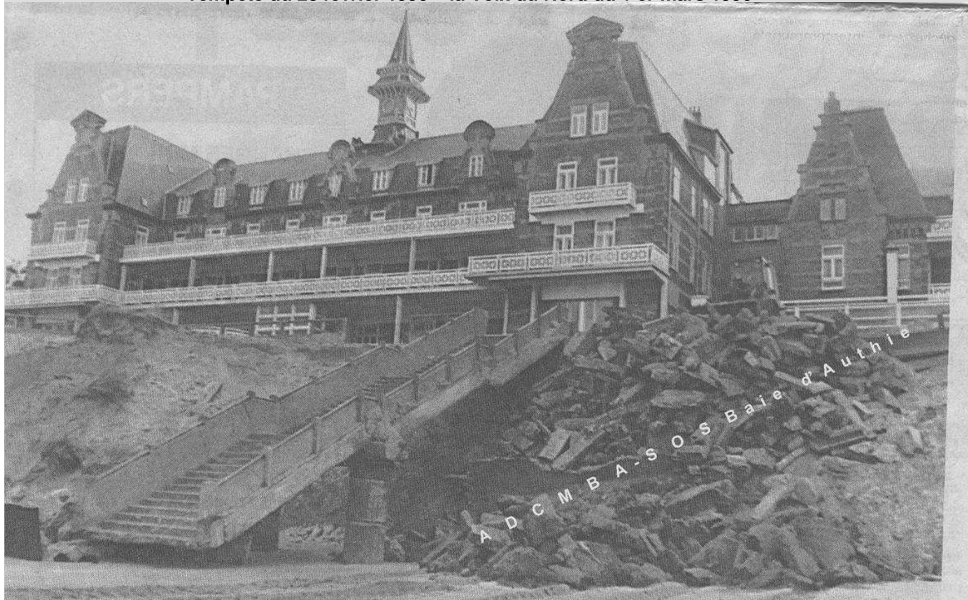
Les escaliers de l'institut Calot qui descendaient sur la plage ont été entièrement découverts.
