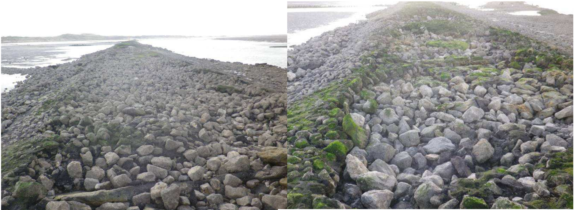
La digue submersible en août 2014, extraits
