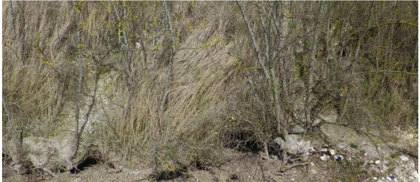
Erosion de la base
